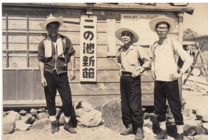
昭和42年7月御岳山夏山公衆電話の開通試験の写真 です。山小屋一軒一軒に設置してある磁石式電話の電池 取り換えと開通試験でした。
