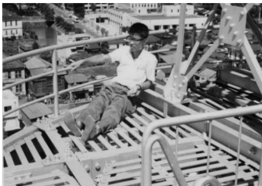
同年、西館屋上パラボラアンテナの上でリラックス？ している本人 怖くないの!!
