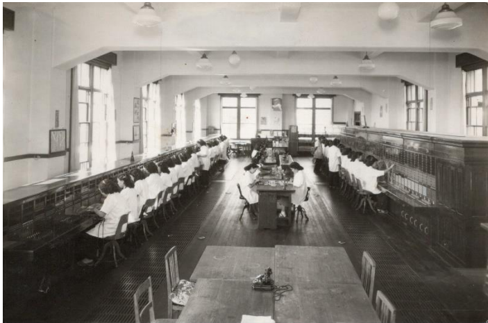
昭和 40 年頃 松本局旧館 2 階の交換室風景
