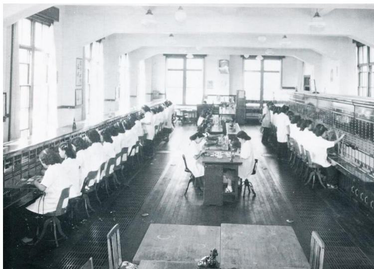
昭和 24～25 年頃 交換室風景
