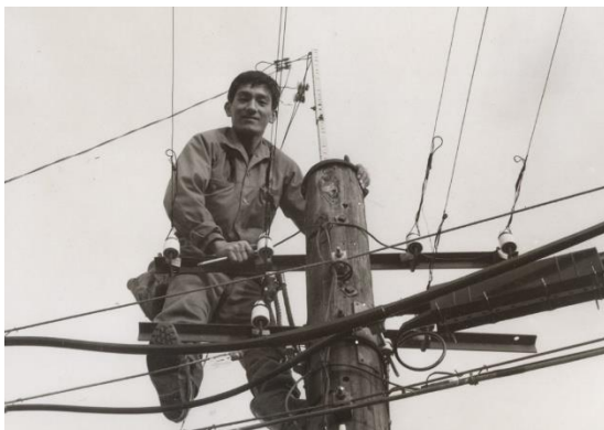
若き頃の作業風景 ヘルメット無し?・・・ 昔のことです
